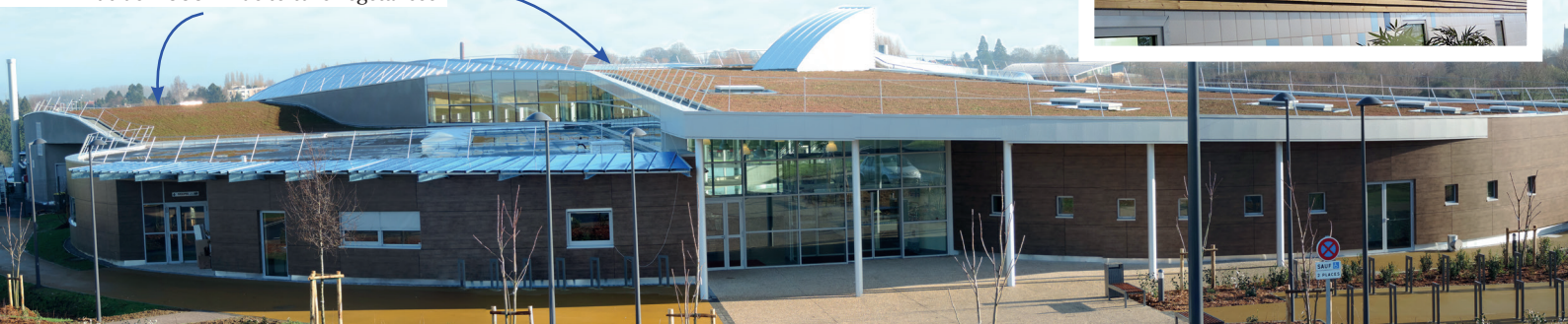
Plus de 2 000 m 2 de toiture végétalisée
