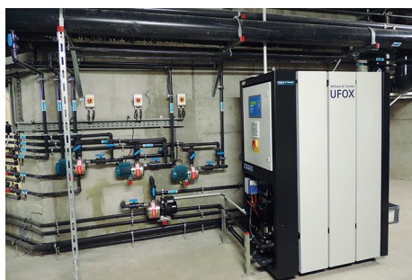
Ci-dessus : l'ultrafiltration clarifie et désinfecte l'eau sans utilisation de produits chimiques. Une fois traitée, elle est réinjectée dans le système de tuyauterie et permet de faire de grosses économies en consommation d'eau.
