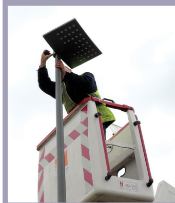
Cette opération illustre parfaitement les futures opérations du passage en LED. Le service éclairage public modernise ici les luminaires d'un quartier d'Avesnes-les-Aubert.
