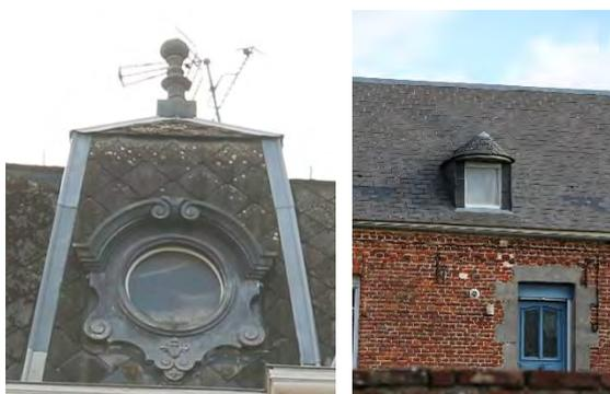
Figure 42 : Lucarne œil de bœuf façonnée en zinc et surmontée d'un fleuron et lucarne en poivrière
