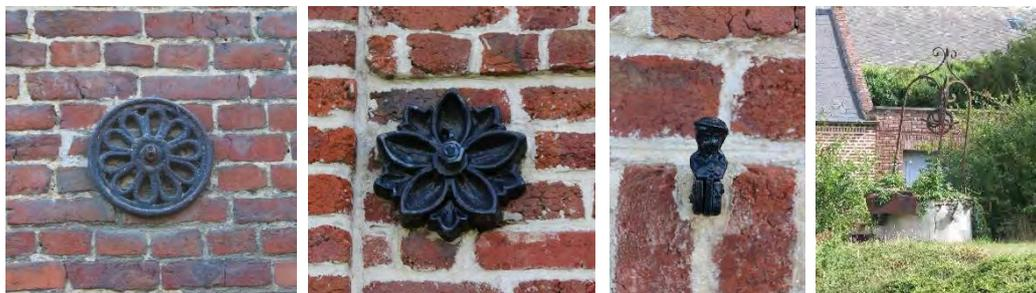
Figure 47 : Diversité de fers d'ancrage - arrêt de persiennes à bascule – ancien puits
